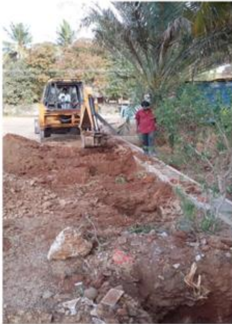
Baggerarbeiten fürs Fundament
