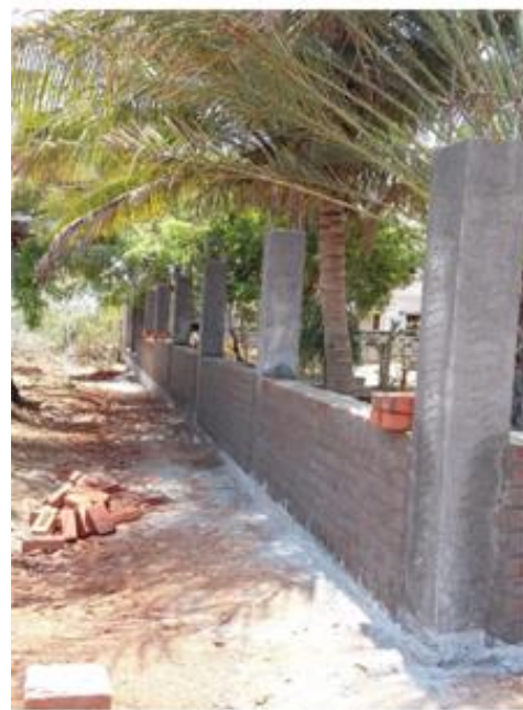
Hochmauern zwischen den Pfeilern
