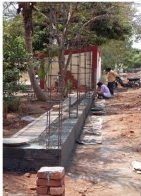
Fundament mit Stahlbetonpfeilern
