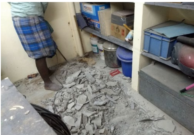
Schaffung eines Zugangs zum Abwassertank und Abpumpen des Inhalts
